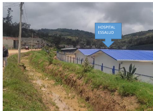
FIGURA N°01: MATERIAL COLMATADO EN EL CAUCE DE LA QUEBRADA HUACACORRAL, CON UNA PROFUNDIDAD PROMEDIO DE 0.5 M.
