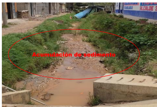
FIGURA N°02: EN LA TEMPORADA DE MAXIMAS AVENIDAS, EXISTE EL RIESGO DE DESBORDAMIENTO, POR LA MARGEN DE CHECHA, PONIENDO EN PELIGRO AL HOSPITAL ESSALUD.
